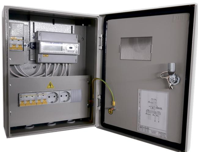
Щитки квартирные предназначены для приема и распределения электроэнергии к потребителям. Так же функцией щитков является защита линий потребителей от перегрузок и коротких замыканий в сетях с глухозаземленной нейтралью напряжением 380/220 В переменного тока частотой 50 Гц.
